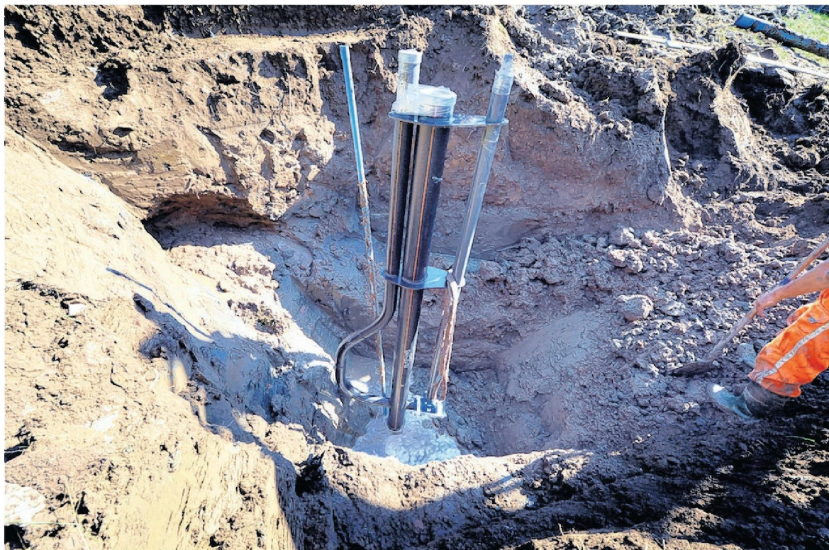
▲ De waterontspanner is eigenlijk niets meer dan een ruim 10 meter lange buis van pvc. Eenvoudig ontwerp, maar effectief, menen de ontwikkelaars. FOTO TON BORSBOOM
